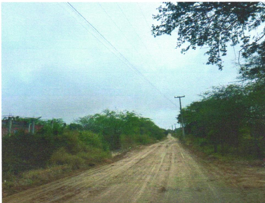
FOTO 05 - EXECUÇÃO E COMPACTAÇÃO DE BASE E OU SUB BASE PARA PAVIMENTAÇÃO DE SOLO ESTABILIZADO GRANULOMETRICAMENTE SEM MISTURA DE SOLOS - EXCLUSIVE SOLO, ESCAVAÇÃO, CARGA E TRANSPORTE. AF_11/2023
