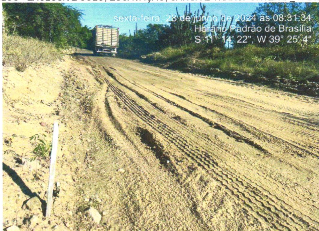
FOTO 06 - EXECUÇÃO E COMPACTAÇÃO DE BASE E OU SUB BASE PARA PAVIMENTAÇÃO DE SOLO ESTABILIZADO GRANULOMETRICAMENTE SEM MISTURA DE SOLOS - EXCLUSIVE SOLO, ESCAVAÇÃO, CARGA E TRANSPORTE. AF_11/2023
